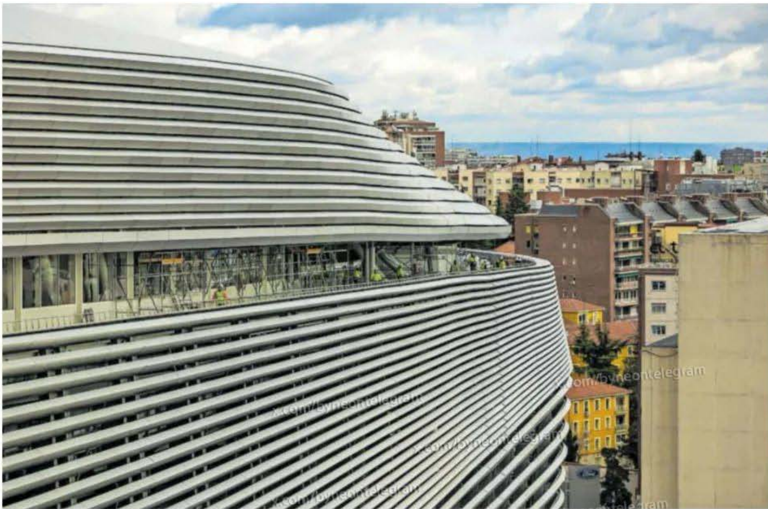
Obras en la parte exterior del estadio Santiago Bernabéu, el viernes. SAMUEL SÁNCHEZ
